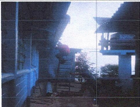
Foto 7: Trabajo durante la sustitución de canales
