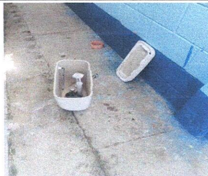
Foto 8: trabajo durante la sustitucion de loza sanitaria
