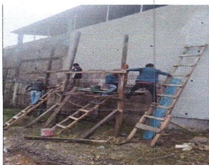
Foto 9: Trabajo durante el repello de muro
